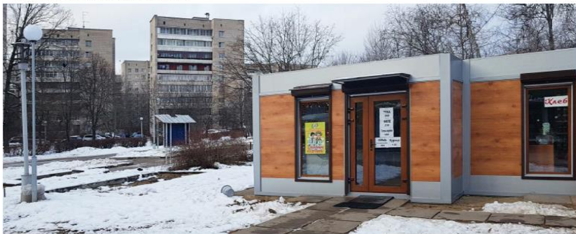
Фотофиксация существующего положения
