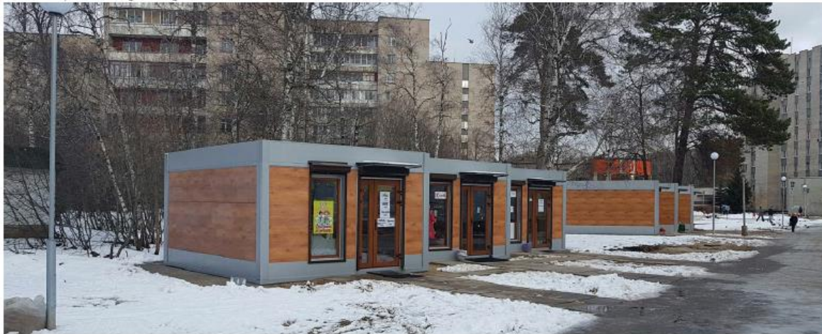
Фотофиксация существующего положения
