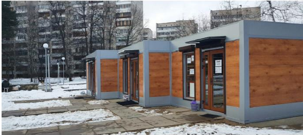
Фотофиксация существующего положения
