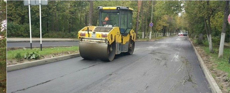
Ремонт автодорог и внутриквартальных проездов
